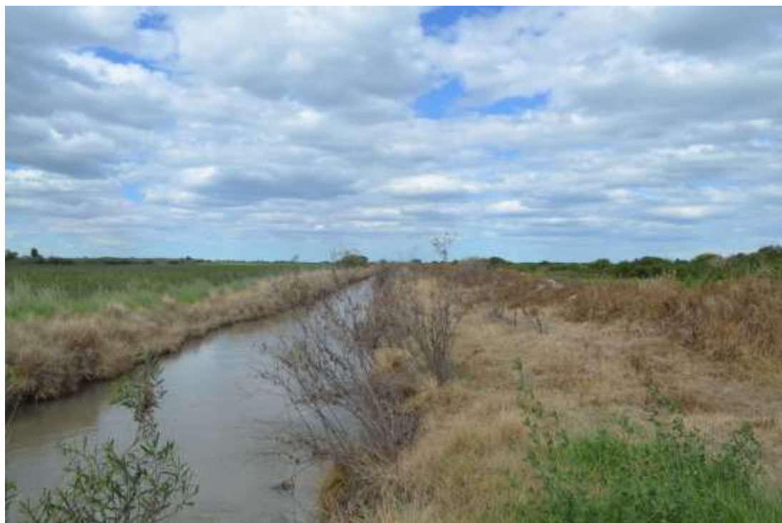
Aguas debajo de primer puente de calle del canal F1
