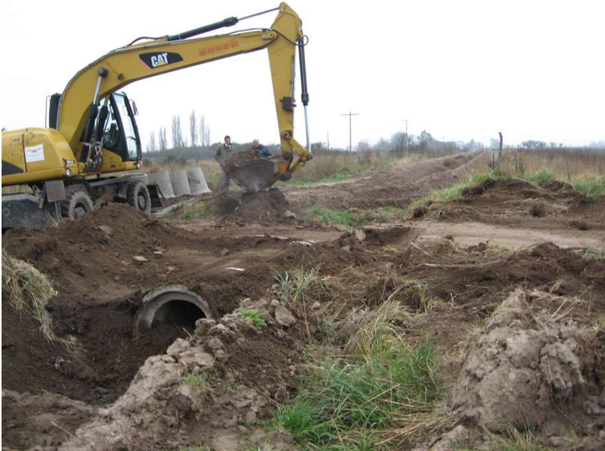
Colocación de puente de calle del canal S2 Prima
