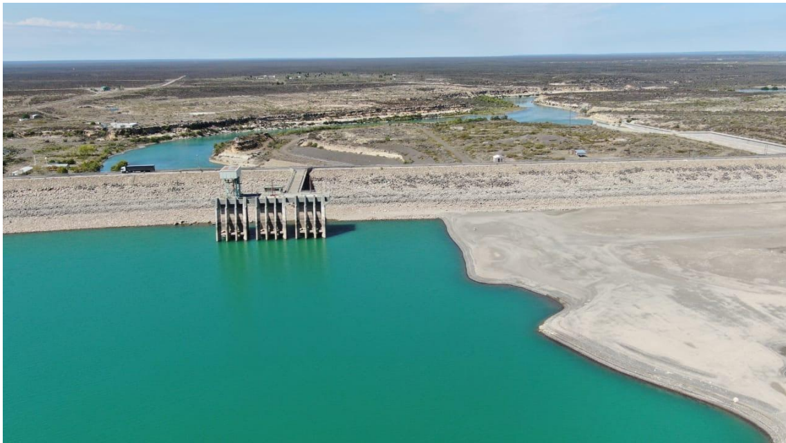
El dique Casa de Piedra en el año 2005
